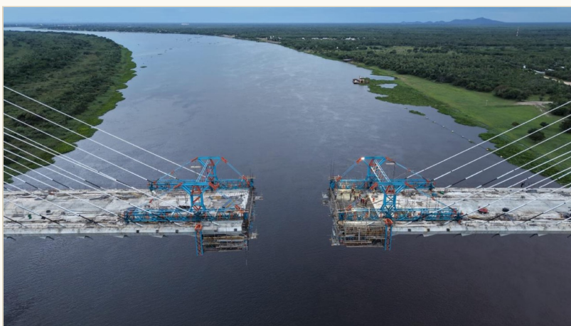
Ponte internacional da Bioceânica em construção (jun-2026) — a 55 km. O driver de valorização.
