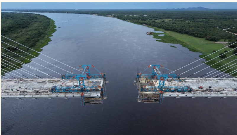
Puente internacional de la Bioceánica en construcción (jun-2026) — a 55 km. El driver de plusvalía.
